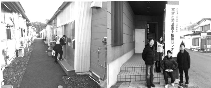
仮設住宅の様子
